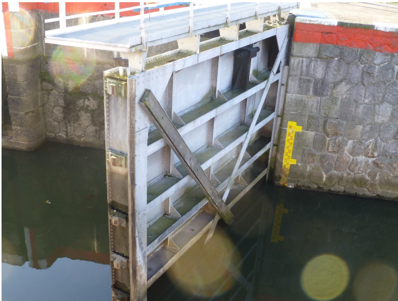
Srazové těsnění a opěrky
