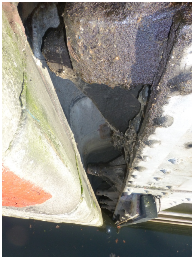
Boční těsnění a opěrky
