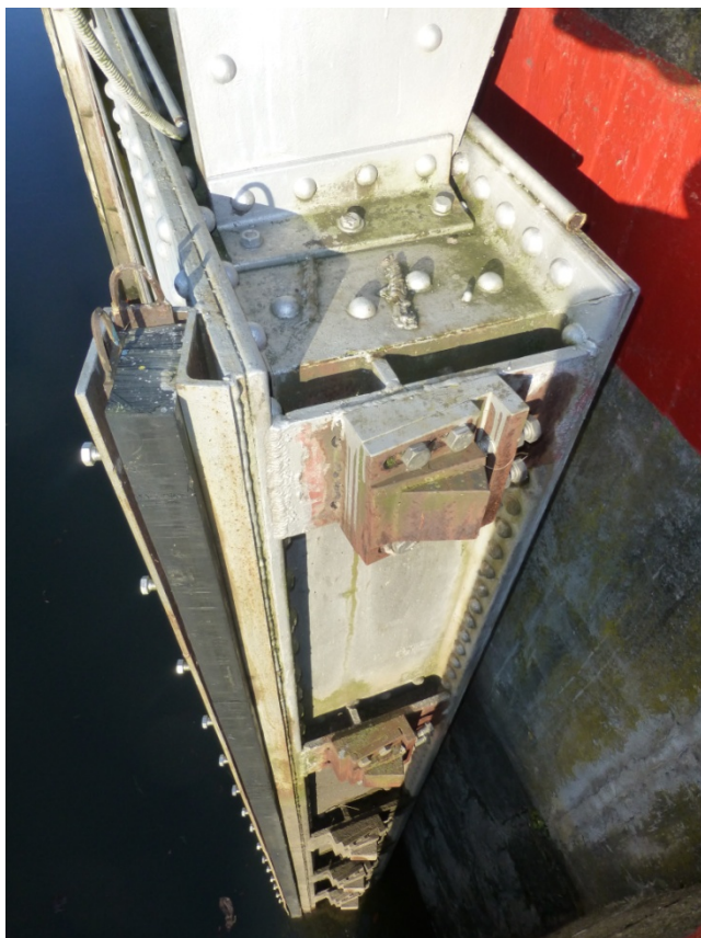
Srazové těsnění a opěrky
